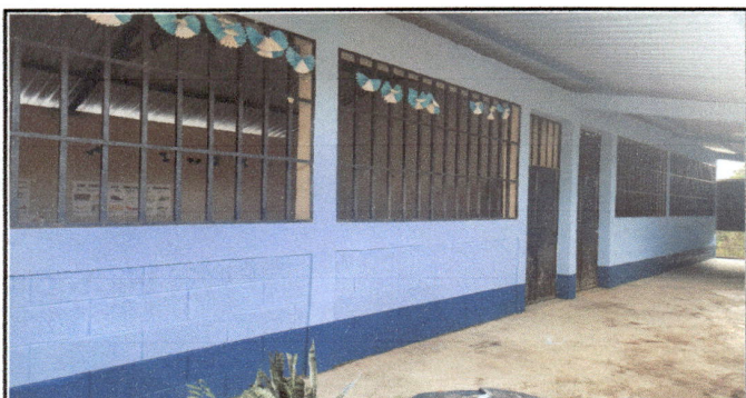
Foto 5: LA IMAGEN EVIDENCIA COMO QUEDO TERMINADO EL TRABAJO DE PINTURA EXTERIOR DEL CENTRO EDUCATIVO
