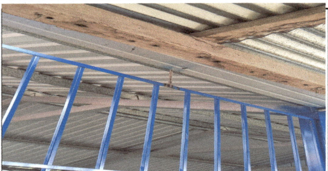
Foto 3: SE PUEDE OBSERVAR YA INSTALADO EL BALCON DEL AULA
