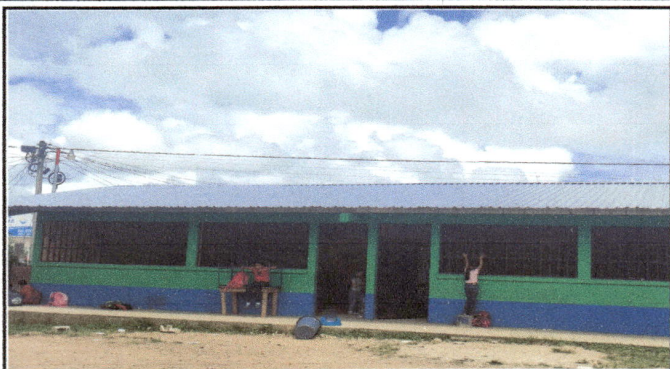
Foto 1: SE OBSERVA LA FINALIZACION DE INSTALACION DE LA CUBIERTA DE LAMINA TROQUELADA CALIBRE 26.
