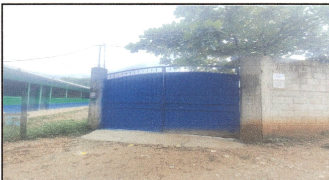
Foto 6: SE OBSERVA YA INSTALADO EL PORTON DE LA ENTRADA PRINCIPAL DEL CENTRO EDUCATIVO PUBLICO.
