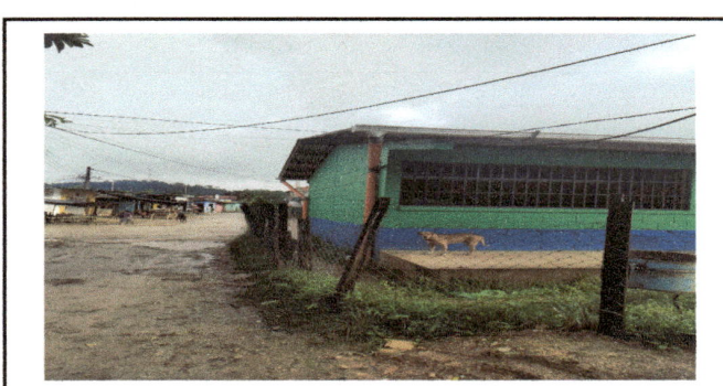
Foto 4: EN LA IMAGEN SE EVIDENCIA COMO QUEDO FINALIZADO LA INSTALACION DE LOS CANALES DE BAJADA DE AGUA CON SUS TUBOS.
